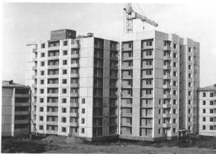
Рис.1. Опытные 10-этажные блок-секции серии И-163.02 в г. Ангарске (слева – подвергнутая вибрационным испытаниям, справа – контрольная)
